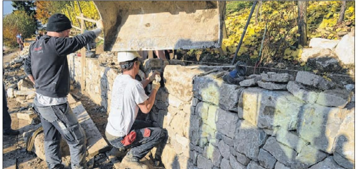
Eine neue Trockenmauer ersetzt an der Neusatzstrasse am Anfang des Muttentzer Rebbergs die bisherige Betonmauer. Die Erstellung erfordert viel handwerkliches Geschick und Kraft. Fotos Daniel Schaub
