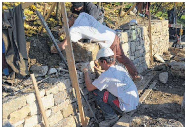
Über eine Tonne Naturstein wird auf einem sichtbaren Quadratmeter verbaut. Die Abschlusssteine müssen zum Passen gebracht werden.
