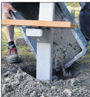
Ist die Platzierung bestimmt, werden die Sockel einbetoniert.
