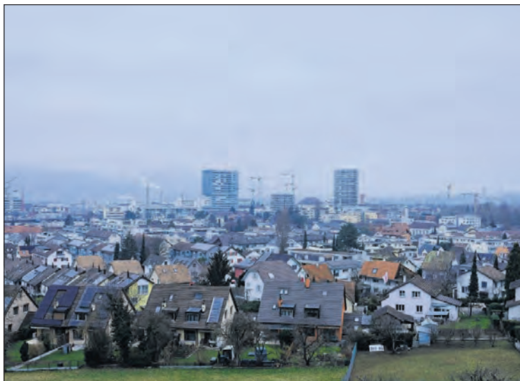
In den letzten Jahren wurden auf zahlreichen Prattler Dächern Solaranlagen installiert.
