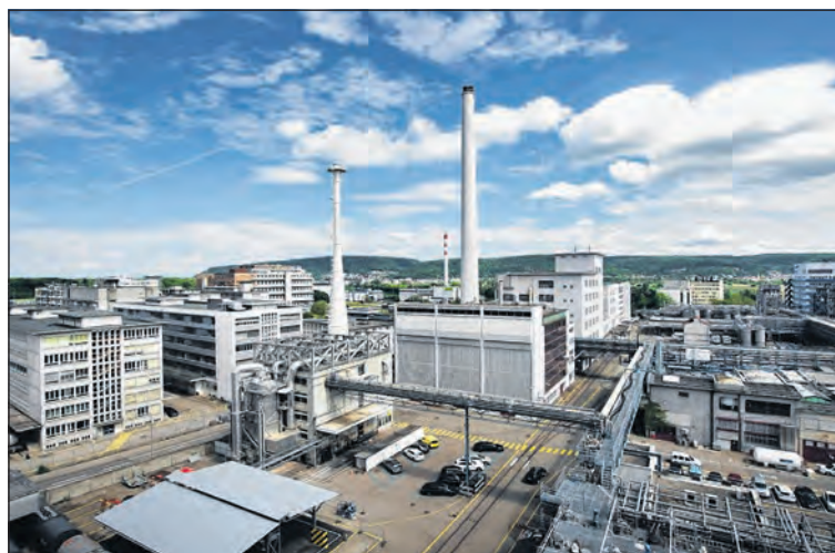
Abwärme aus dem GETEX PARK.SWISS wird in das Fernwärmenetz eingespeist und füllt den gestiegenen Bedarf in Pratteln.
