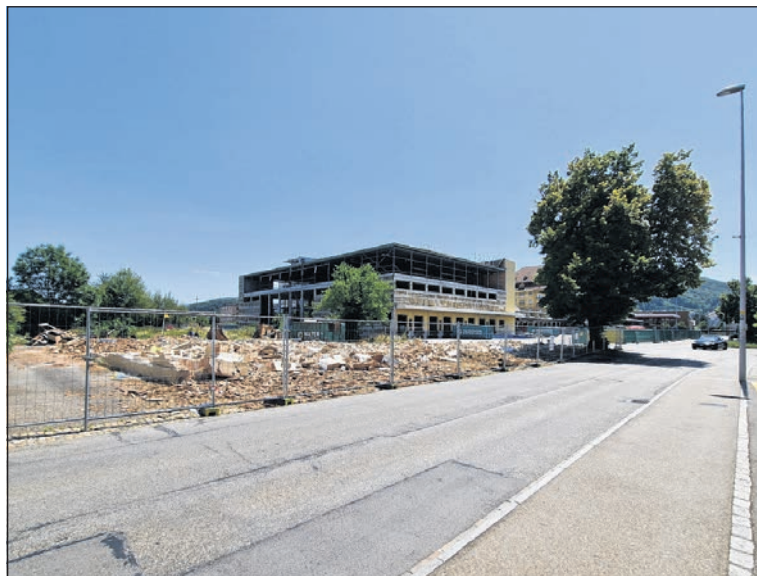
Nicht nur der Bauernhof wurde dieser Tage Opfer der Spitzhacke. Jetzt fällt das 1983 anstelle der Sägerei Hertner errichtete, grosse Gebäude der alten Coop-Verteilzentrale dem Wohnungsbau zum Opfer. Hoffentlich überlebt die markante Linde.
