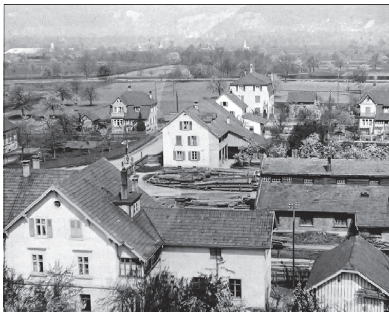
Gerade mal etwa 113 Jahre alt ist das letzte Bauernhaus in Neu-Pratteln geworden (Bildmitte). Einzig ein Relikt des Hohenrainhofs überlebt an der Zurlindenstrasse als Restaurant.
