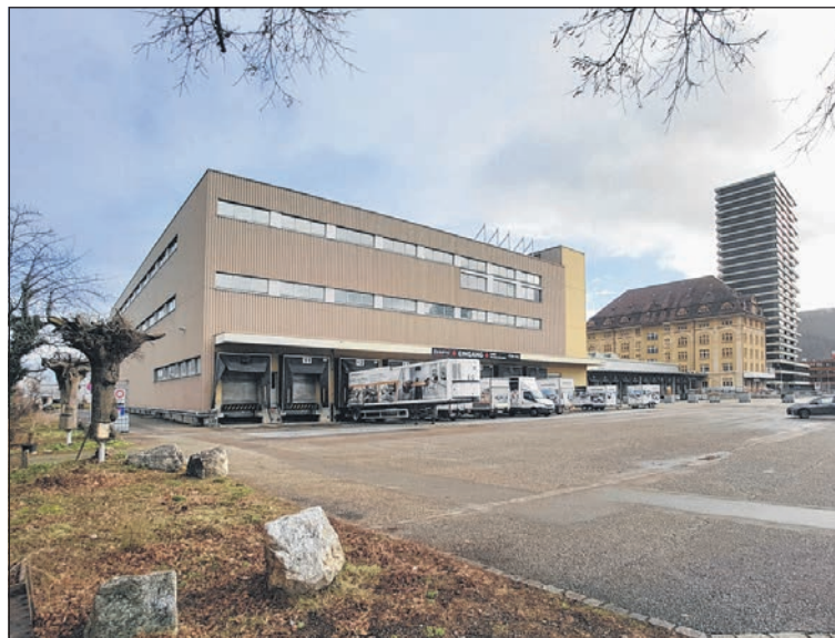
Menschen werden immer älter. Für Bauwerke gilt das Gegenteil. Nur gerade 40 Jahre alt ist dieses Logistik-Gebäude geworden. Wenn man denkt, das Kolosseum hat 2000 Jahre überdauert. Fotografiert aus dem Schatten der Linde am 9. Januar 2022.
