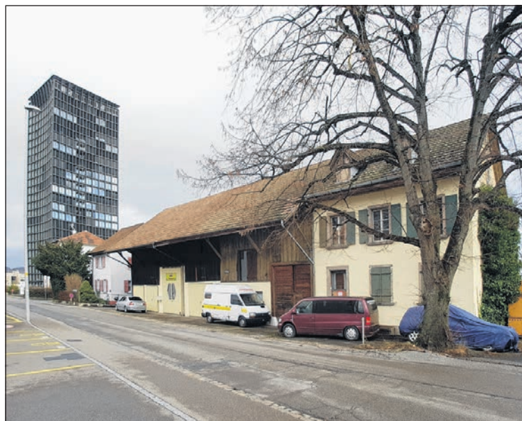
Das Abbruchobjekt «Weber Sämi», so hiess der Bauer am Gallenweg. Mehr über die Ausrichtung des Hofes erfahren Sie im Buch «Pratteln und seine Bauern vor 70 Jahren» von Ruedi Pfirter. Das Foto entstand im Januar 2022 für die Bebilderung der Broschüre.
